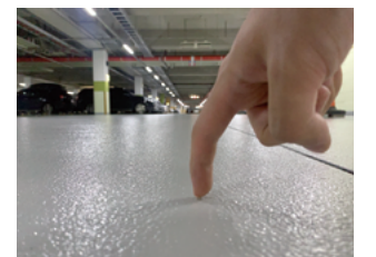
〈 에폭시 엠보 시공 사례 〉
