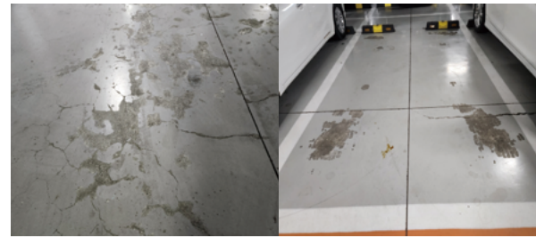
〈 저점도 에폭시, 저가 에폭시로 시공한 지하주차장 바닥 사례 〉
