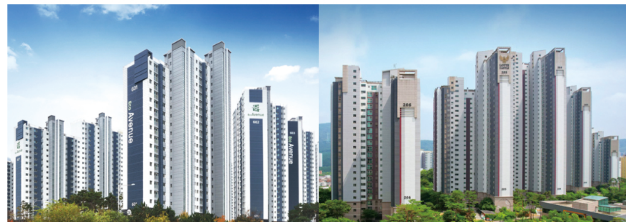
*인천 서창 에코에비뉴 (855세대 / 2022년 시공)
