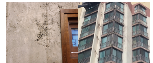
〈 재도장한 지 만 3년 이내에 심각하게 발생한 탈색된 외벽 수성페인트 〉
