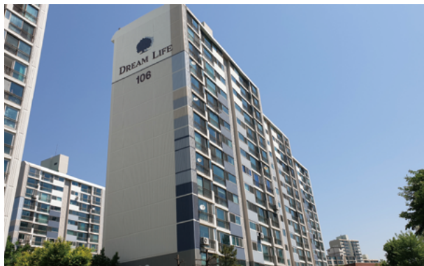
〈 고내후성 외벽 수성페인트를 칠한지 4년 경과된 아파트로 외벽 색상이 선명하다 〉
